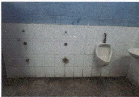
Foto 9: 10.8 Sustrucción de mingitorio
