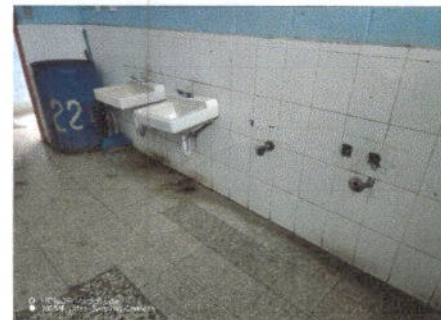
Foto 6: 10.5 Sustitución de lavamanos
