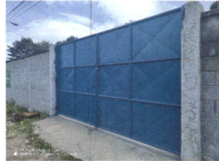
Foto 2: 12.1 Mantenimiento a estructura (lijado, cambio de tuvo, sepillado, sujeciones y aplicación de pintura)
