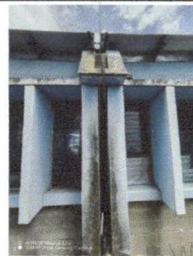
Foto 4: 7 Reparación de bajada de agua pluvial
