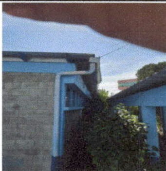
Foto 11: 7.5 sustitución de soporte o pescante para canal
