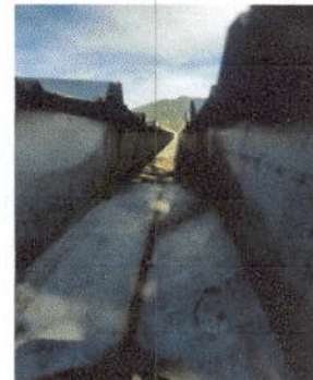
Foto 10: 7 Reparación de bajada de agua pluvial
