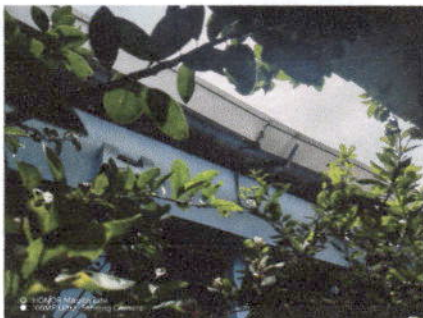
Foto 5: 7.5 sustitución de soporte o pescante para canal
