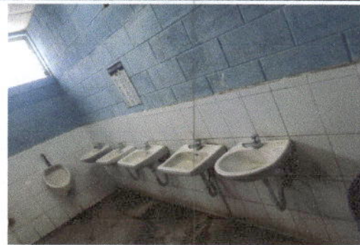
Foto 12: 10.5 Sustrucción de lavamanos
