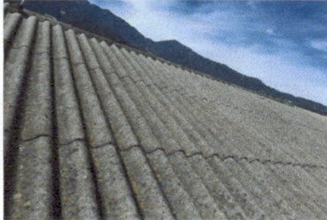
Foto 7: 1.3 Sustrucción de elementos de fijación
